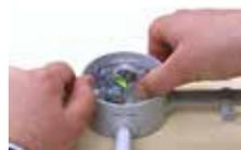
Cubre las conexiones, prestando atención no dejar áreas de vacío entre los contactos
